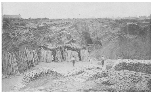
Carrière d'échalas (pieux pour les vignes) à Roc Epine à Angers (314 J)
